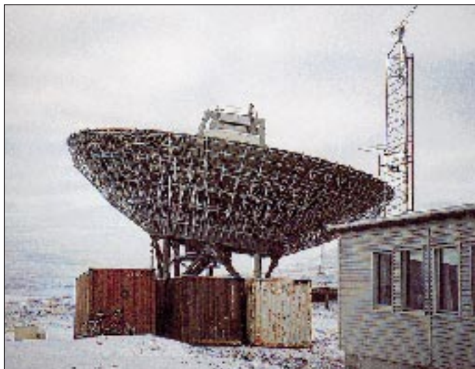
Svalbard-Radar: Die nicht schwenkbare 48-m-Parabolantenne. Zum Zeitpunkt unseres Besuches befand sie sich knapp vor der Inbetriebnahme.
